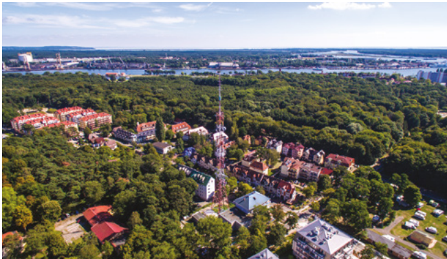
Świnoujście Mast, Świnoujście, Poland.
